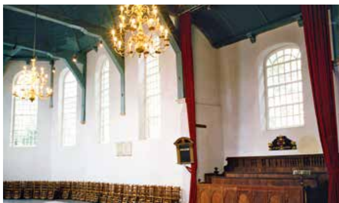
Das Mauerwerk dieser Gebäude wurde mit KÖSTER Sanierputz weiß instand gesetzt.
