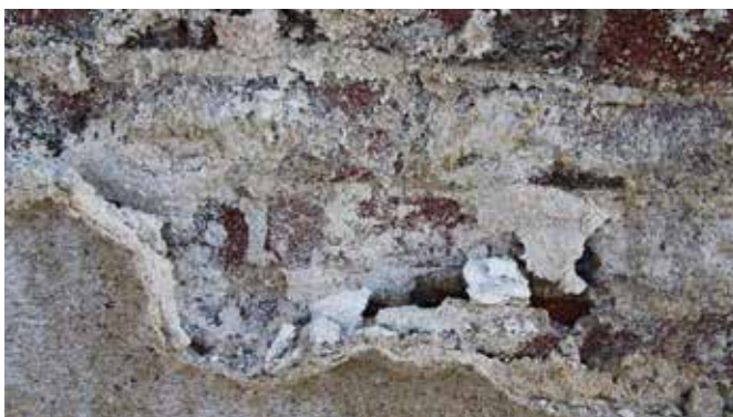
Typischer Schaden durch Salzausblühungen
