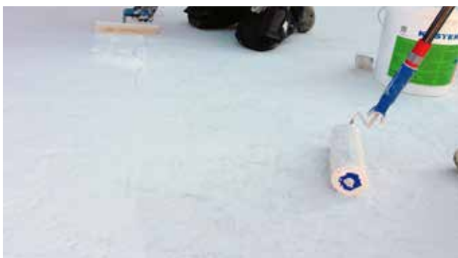
Auftragen der zweiten Lage KÖSTER 21
