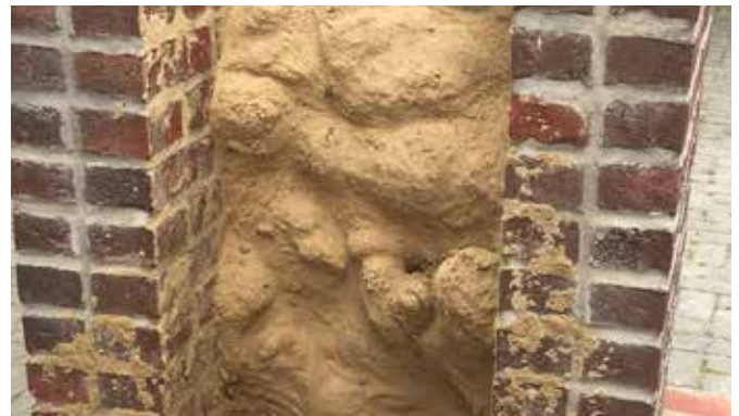
Schleierinjektion (rückseitige Ansicht)
