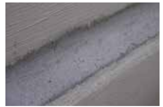
Ausgerundete Hohlkehle aus KÖSTER Sperrmörtel WU
