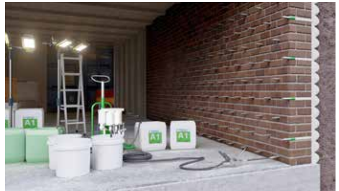
Mauerwerk Schleierinjektion
