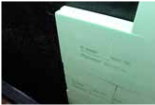
Mit KÖSTER Deuxan 2K lassen sich Dämmplatten leicht an der Abdichtung befestigen. Wichtig ist dabei eine vollflächige Verklebung.
