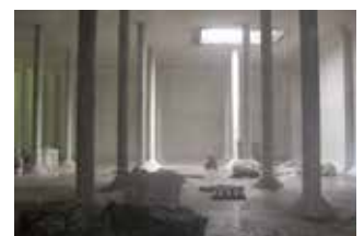
Positivabdichtung in einem Tank mit KÖSTER NB 1 grau
