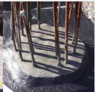
Anschluss der Flächenabdichtung (KÖSTER Deuxan 2K) an die Abdichtung des Pfahlkopfes
