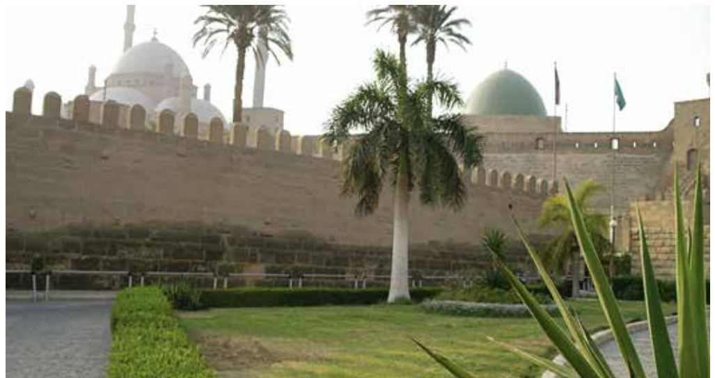
Ein Beispiel für aufsteigende Feuchtigkeit
