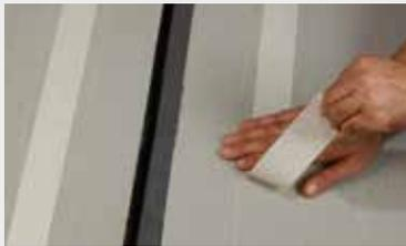
Beide Seiten der Fuge werden mit Klebeband abgeklebt.
