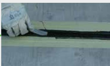
Die Fugenmasse ist oberflächlich, z.B. mit einem Spachtel, zu glätten. Das Klebeband sollte vor Erhärten des Fugenspachtels entfernt werden.
