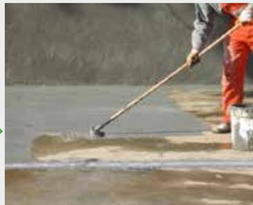
Die Flächenabdichtung wird mit KÖSTER NB 1 grau durchgeführt, einer mineralischen Abdichtung gegen Bodenfeuchtigkeit, nichtdrückendes und drückendes Wasser. KÖSTER NB 1 grau ist beständig gegen positiven und negativen Wasserdruck.
