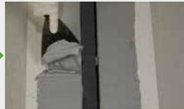
A- und B-Komponente des KÖSTER KB-Pox Klebers werden laut technischem Merkblatt angemischt bis eine gleichmäßige graue Farbe erreicht wird und auf beiden Seiten ca. 2 mm stark aufgetragen.
