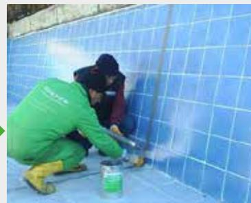
Die horizontalen Fugen werden mit dem selbstverlaufenden KÖSTER Fugenspachtel FS-H abgedichtet. Der standfeste KÖSTER Fugenspachtel FS-V wird für die Abdichtung der vertikalen Fugen eingesetzt. KÖSTER Fugenspachtel verfügen über eine hohe mechanische Belastbarkeit und eine sehr gute Rückstellfähigkeit.
