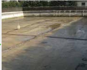
Die Oberfläche wird bis zur tragfähigen Substanz abgetragen. Der Untergrund muss sauber, frei von Staub und anderen Verunreinigungen sein.
