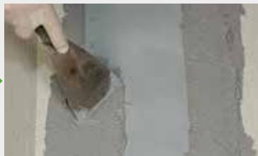
Unmittelbar im Anschluss daran wird eine zweite Lage Kleber auf das KÖSTER Fugenband und den neben dem Band aufgetragenen Kleber aufgetragen. Die Mitte der Fugenbänder bleibt frei.
