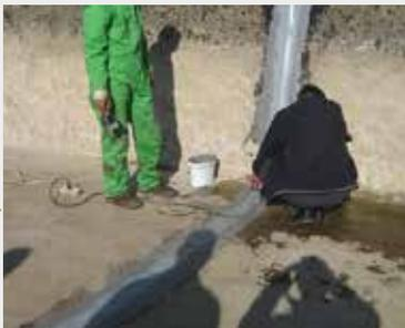
Anschlüsse werden mit einem Heißluft-Schweißgerät verbunden, Nähte sollten mindestens 2 cm überlappen.
