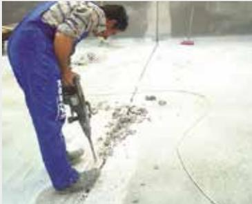
Im ersten Schritt werden die Rückstände der Betonierarbeiten entfernt.
