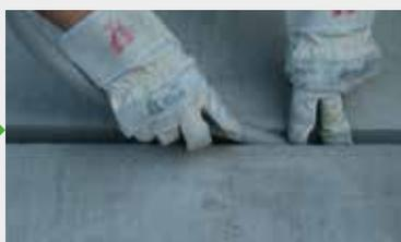
Um Beschädigungen am Fugendichtstoff durch Bewegungen in unterschiedliche Richtungen zu vermeiden, wird bei diesem immer nur Kontakt zu zwei Fugenflanken hergestellt. Dazu wird ein Hinterfüllmaterial, z. B. Quarzsand oder eine geschlossenzellige PE-Rundschnur, eingebaut. Eine Dreiflankenhaftung wird so unterbunden.
