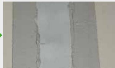
Das Klebeband an beiden Seiten des Fugenbandes muss entfernt werden bevor der Kleber zu erhärten beginnt, so dass eine saubere Begrenzung entsteht.
