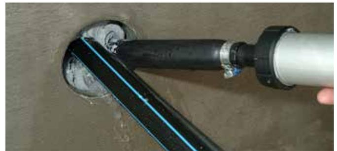
2 Das Material wird mit der KÖSTER Handpistole in den Raum zwischen Kabel und Wand gepresst und das Wasser dauerhaft gestoppt.
