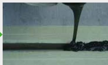
Das Verfüllen der Fuge erfolgt ca. 30 Minuten nach Aufbringen von KÖSTER FS Primer 2K, wenn der Primer noch leicht klebrig ist.
