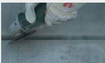
Die Fugenflanken werden vor der Verarbeitung des Fugenspachtels abgefast. Die Fase ist mind. 10 mm breit und erfolgt in einem 45°-Winkel.
