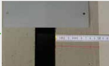
Das KÖSTER Fugenband 20 mind. 4 cm, das KÖSTER Fugenband 30 mind. 5 cm breit in den KÖSTER KB-Pox Kleber einbetten. Der Kleber wird ca. 2 cm breiter als die Bandbreite aufgebracht.
