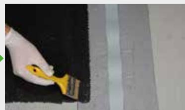
Das fertig eingebaute Band muss 24 Stunden erhärten. Danach kann die Flächenabdichtung überlappend auf den Kleber aufgetragen werden.
