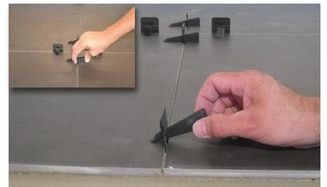
**6** Anschließend erfolgt das Einschieben der Spannkeile in die T-förmigen Zugplatten auf der Oberseite der Fliesen. Keile mit der Hand andrücken, bis eine leichte Spannung erreicht wird.
