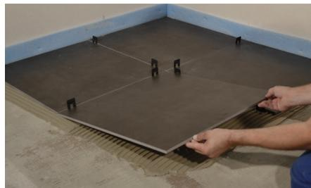
**5** Die nächste Fliese wird bis an die T-förmigen Zugplatten angelegt und unter Druck in das Mörtelbett eingelegt. Die Zugplatten geben gleichzeitig eine Mindestfugenbreite von 2 mm vor. Breitere Fugen sind möglich.
