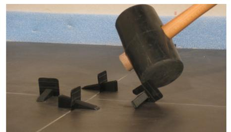
**9** Nach Begehbarkeit des Belags werden die herausstehenden Zugplatten abgeschlagen. Die Keile können mehrfach verwendet werden. Belag verfugen.
