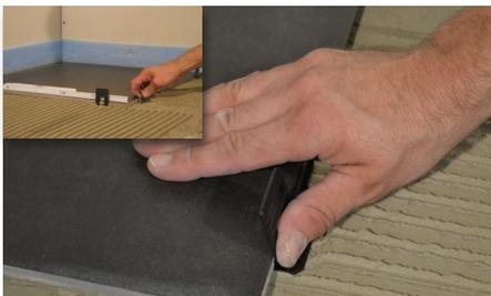
**4** Die T-förmigen Zugplatten unter leichtem Druck in das Mörtelbett eindrücken und bis zur Fliesenflanke schieben. Die Platzierung (von mind. 2 Stück pro Fliesenflanke) erfolgt ca. 5 cm von der jeweiligen Fliesenecke.
