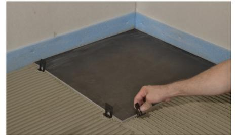
**3** Die erste Fliese wird in das frische Mörtelbett eingelegt. Anschließend werden die T-förmigen Zugplatten unter die Fliesenkante geschoben. Die Anzahl ist dem Fliesenformat nach der Tabelle (siehe Gebinde) zu entnehmen.
