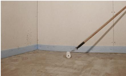
**1** Untergründe müssen für die Verlegung der Fliesen geeignet und ausreichend eben sein. An aufsteigenden Bauteilen sind Randdämmstreifen anzubringen. Abgestimmt auf Untergrund und Dünnbettkleber ist nach Bedarf eine Grundierung aufzubringen.
