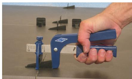
**8** Mit der Spannzange wird der Keil in die Aufnahme gedrückt und presst so den Keil an die Zugplatte. Die Kanten sind auf einer Höhe ausgerichtet.
