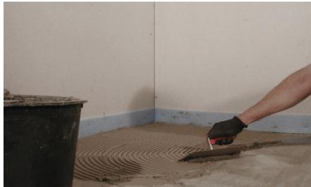
**2** Auf den vorbereiteten Untergrund wird der Dünnbettörtel mit der auf die Fliese abgestimmten Zahntraufel aufgekämmt. Auf der Fliesen-/Plattenrückseite ist eine Kontaktschicht und gegebenenfalls eine Zahnung aufzubringen.
