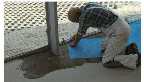
**6** Der Zuschnitt der Entkopplungsmatten auf das erforderliche Maß erfolgt mit einem Messer oder Schere. Nach dem Einlegen der BLANKE PERMAT in das frische Fliesenkleberbett ist die jeweilige Abbindezeit des verwendeten Dünnbettmörtels abzuwarten.
