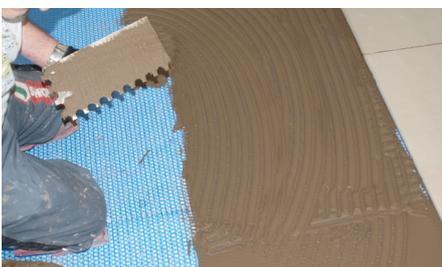
**7** Die Vertiefungen der Gitterstruktur werden mit Fliesenkleber gleichmäßig abgespachtelt. Mit der auf die Fliese abgestimmten Zahntraufel wird dann der Fliesenkleber frisch in frisch aufgekämmt und die Fliesen eingelegt.
