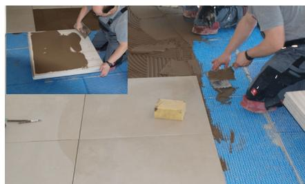
**8** Frühestens nach 24 Std. können die verlegten Fliesen mit Flexfuge nach EN 13888 CG2 verfugt werden.
