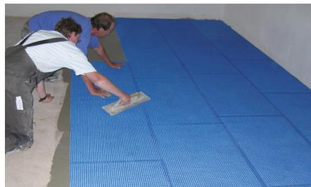
**5** Die Entkopplungsmatte vollflächig in den klebeoffenen Verlegemörtel mit dem Spezialvlies nach unten (weiße Seite) einlegen und mit Hilfe eines Reibbretts andrücken.
