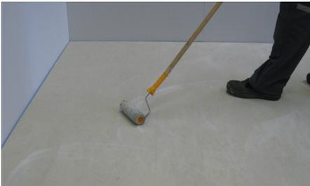
**1** Untergründe müssen frei von haftungsfeindlichen Bestandteilen sein. Die Ebenheit muss der DIN 18202 entsprechen. Der Untergrund muss tragfähig und fest sein. Abgestimmt auf den Untergrund ist eine Grundierung aufzubringen.
